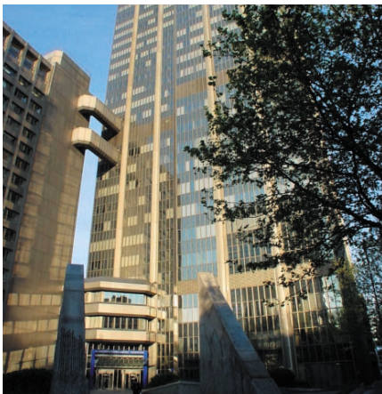
LVA Rheinprovinz – Eingangsbereich Gebäude Düsseldorf
